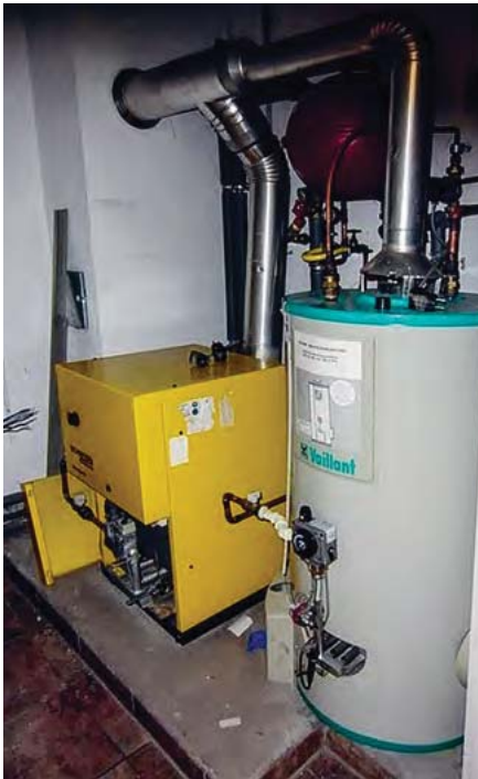
Abbildungen 70 und 71: Erkundung von Heizanlagen.
