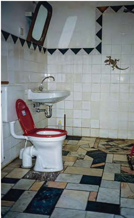
Abbildung 59: Zuschnitt des Bodenbelags aus Marmorresten und verschiedenen Wandfliesen zusammengestellt.
