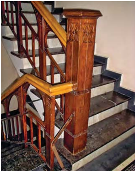
Abbildung 69: Treppenbauteile zum Ausbau.
