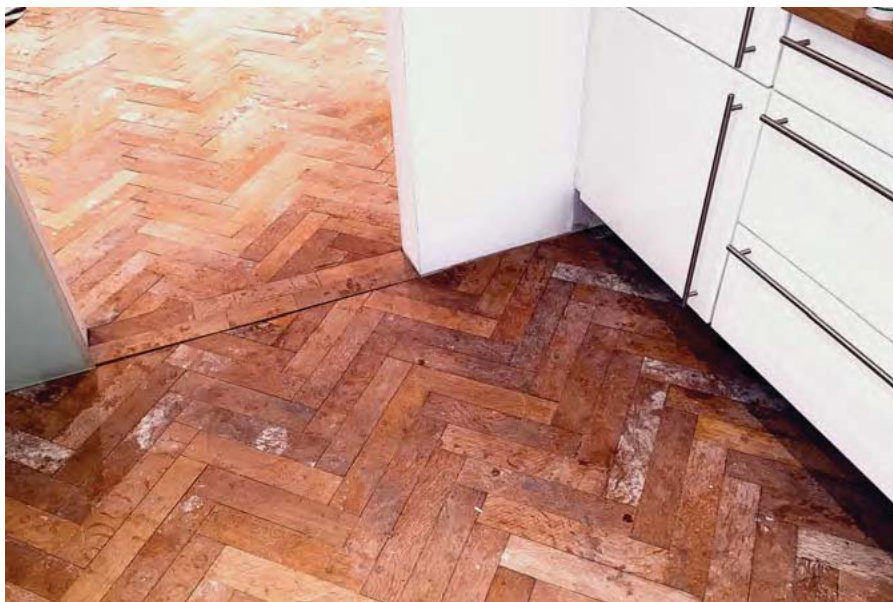
Abbildung 54: Neuverlegung Mischparkett Eiche, Kirsche, Buche.
