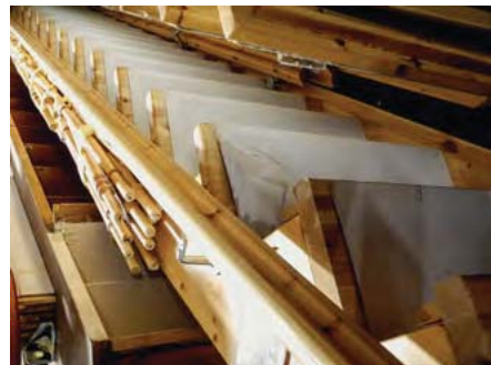
Abbildung 64: Geschützte eingelagerte moderne Treppe.
