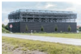
Geothermiewerk der Stadtwerke München in Sauerlach. 23 Bis 2040 wollen sie das gesamte Fernwärmenetz aus erneuerbaren Quellen bestreiten. [b8]
